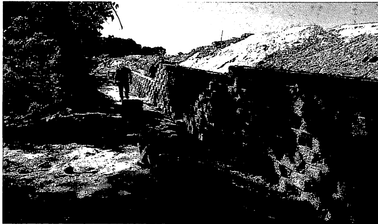
Muro Mesa en lado Nor-este del proyecto
