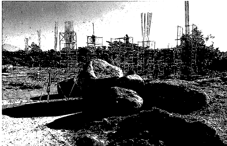
Retiro de Roca en área de zapatas de edificio de Tecnología del Automóvil.
